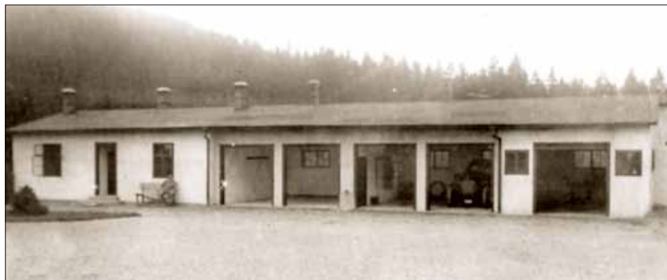
Nově postavené garáže patří k hradu Bouzov (cca 1910). Později byly zbourány, aby mohl být zvětšen hradní park, ve kterém budou při Hanáckém okruhu vozidla vystavena
